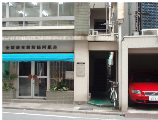
Photo2 建物の入口(右脇の外付け階段)
